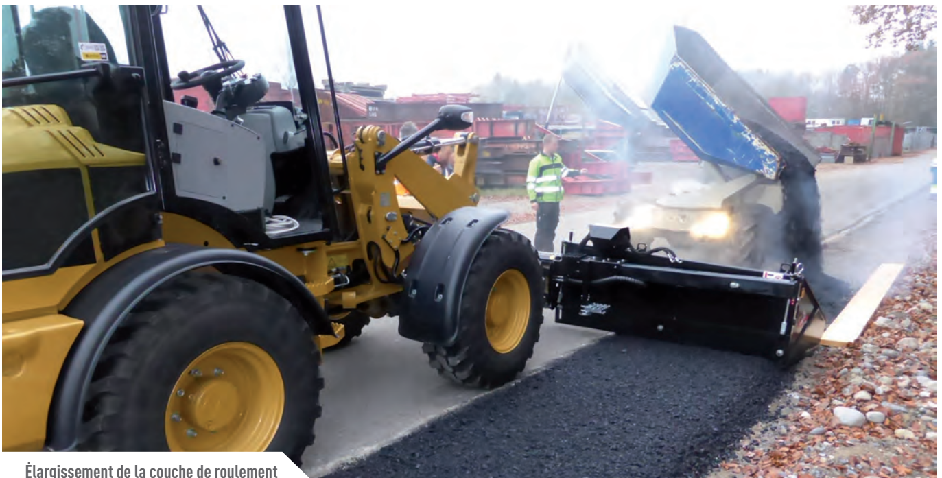
Épandage d'enrobé sur trottoir
