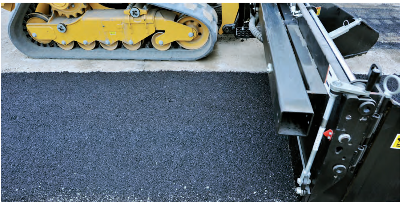
Élargissement de la couche de roulement
